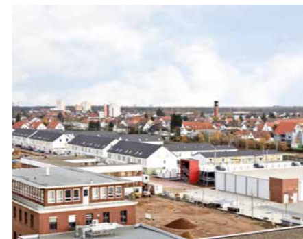
Kelsterbach Wohn- und Gewerbegebiet „Mainblick“ Kraft-Wärme-Kopplungsanlage (Erdgas) in Kombination mit Photovoltaik-Anlage und Stromspeicher
