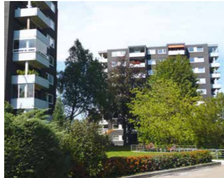
Kleinostheim Schwimmbad Kessel: Holzhackschnittel, Erdgas
