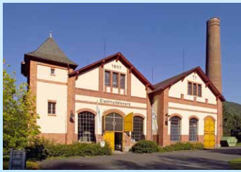
Wasserkraftwerk Friedrichsseggen Baujahr 1906/1907 3 Kaplanurbinen 3 Generatoren, 840 kW Leistung
