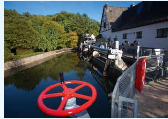
Wasserkraftwerk Altwied Baujahr 1910/1911 3 Francisturbinen 3 Generatoren, 1.200 kW Leistung
