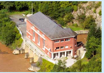
Wasserkraftwerk Cramberg Baujahr 1926/1927 3 Francisturbinen 3 Generatoren, 3.300 kW Leistung
