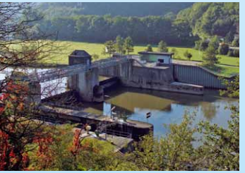
Wasserkraftwerk Nassau Baujahr 1984/85 1 Rohrturbine 1 Generator, 1.400 kW Leistung
