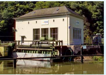
Wasserkraftwerk Kalkofen Baujahr 1954/1955 1 Kaplanurbine 1 Generator, 1.650 kW Leistung
