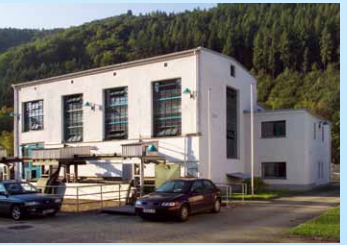
Wasserkraftwerk Elisenhütte Baujahr 1931 2 Kaplanurbinen 2 Generatoren, 1.700 kW Leistung
