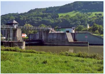
Wasserkraftwerk Dausenau Baujahr 1985/86 1 Rohrturbine 1 Generator, 1.400 kW Leistung
