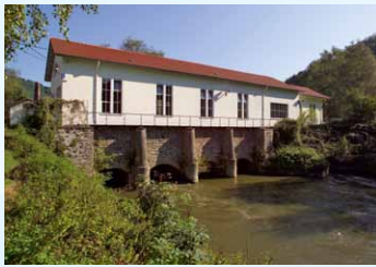
Wasserkraftwerk Fachbach Baujahr 1899 1 Francisturbine, 1 Kaplanurbine 2 Generatoren, 400 kW Leistung
