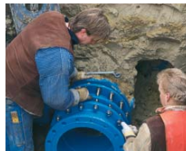
Baumaßnahme im Wasserrohrnetz
