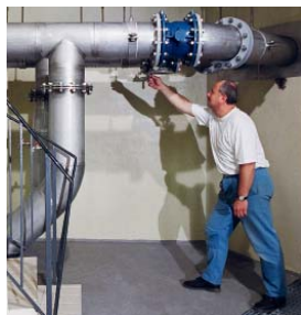
Inspektion eines Rohrkellers
